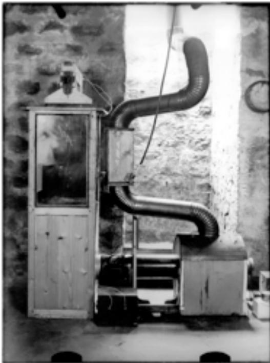
Quatrième et dernière version de la machine à fumée, équipée de 57 canaux,
